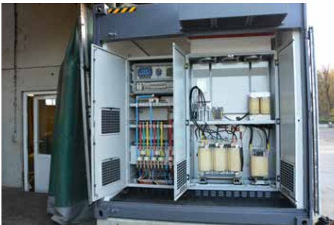
Aan de linkerzijde van de container staan de transformatoren opgesteld. Links (ter hoogte van het groene gordijn) is er een aansluiting voor het noodstroomaggregaat voorzien. Binnen in het gebouw staat het ontkoppelbord met noodschakelaar.
